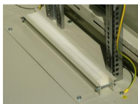
Фото 3: Главные кабельные вводы (правый)
